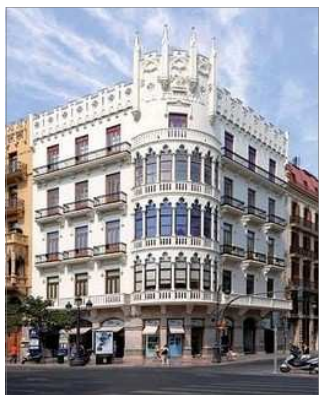
Edifici Suay. Plaça de l'Ajuntament, 23, carrer Correus, 1.
